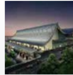
第一航廈改善工程
